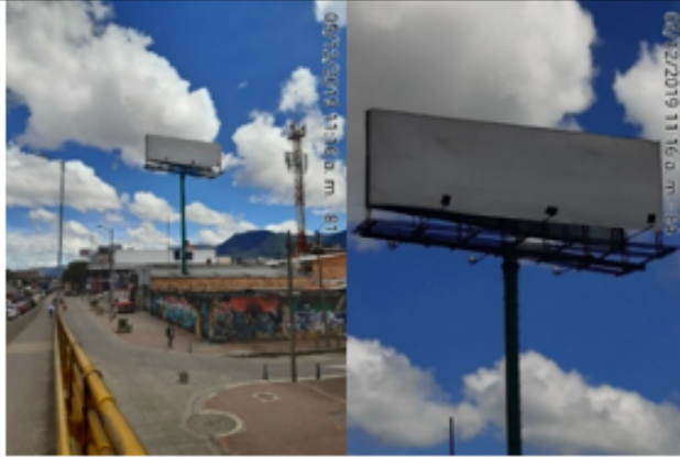
Foto No.1 y 2: Vista panorámica del predio, del mastil y panel y de la estructura de la valla tubular, instalada en la Calle 14 No. 29-60 (dirección catastral), orientación Sur-Norte.
