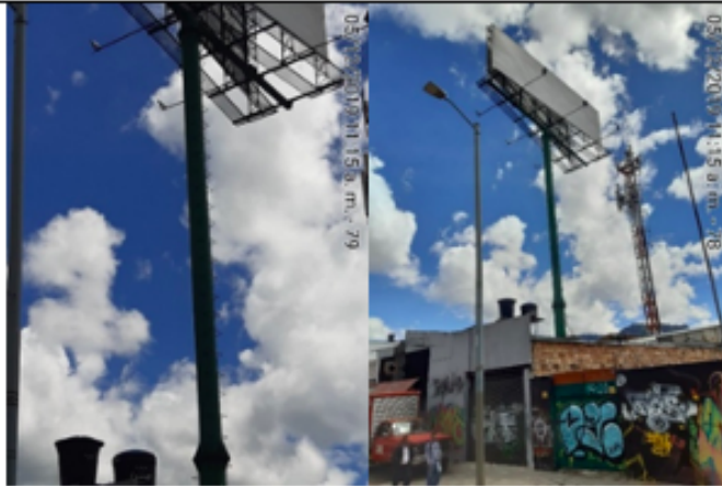
Foto No.3 y 4: Detalle del mastil y de la estructura de la valla, en buenas condiciones y estable, ubicada en la Calle 14 No. 29-60 (dirección catastral), orientación Sur-Norte.
